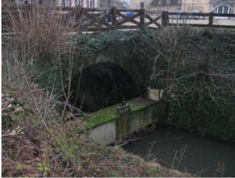
Figure 3 : Vue du seuil interrompant la continuité écologique au niveau du château de VAUGRIGNEUSE
