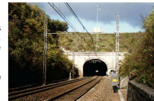
C'est un ouvrage de 504 mètres de longueur, en maçonneries de moellons de calcaires assisés.
