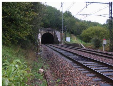
C'est un ouvrage de 426 mètres de longueur, en maçonneries de moellons de calcaires assisés.
