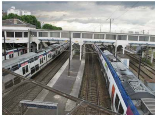
Noisy-le-Sec (Seine-Saint-Denis), hier. Les deux experts qui ont rendu un rapport sur Brétigny évoquent aussi une fissuration des attaches élastiques reliant les rails aux traverses en béton en gare de Noisy. (LP/Sébastien Thomas.)
