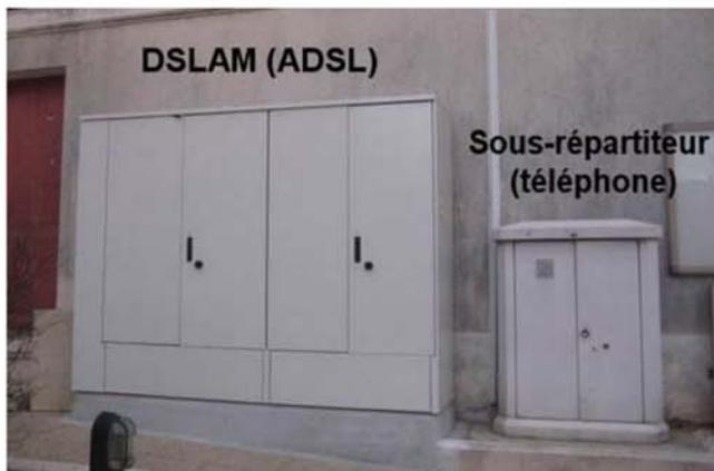
Au final, une ligne située à 6 kilomètres du central téléphonique principal (inélégible avec 80dB) est transférée sur le nouveau NRA-ZO situé à moins de deux kilomètres (souvent moins !). Du coup, son atténuation est divisée par 5 ou par 10 et permet une connexion ADSL performante.
