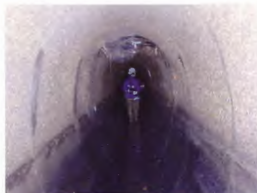
Photo du collecteur intercommunal T200 à Savigny-sur-Orge - source SIAHVY
