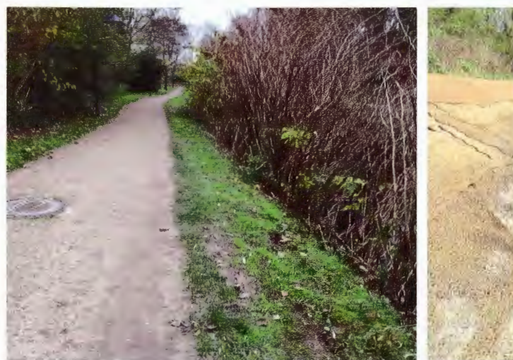
La Boële avant et après les travaux de terrassement d'une station de Renouée
