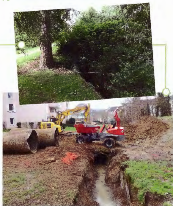
Débusage du Vatencul (avant et pendant les travaux)
