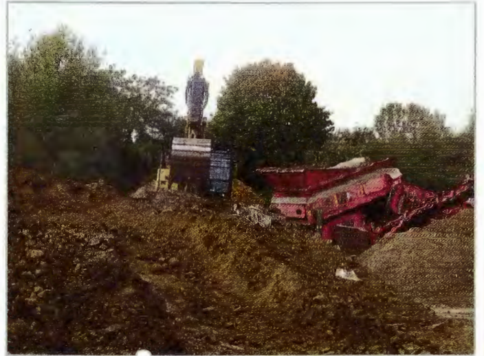
VILLEJUST Traitement des foyers de Renouée en prévision des travaux de restauration du Rouillon
