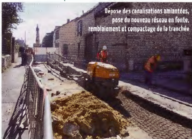
Pose du réseau EU en fonte à profondeur moyenne
