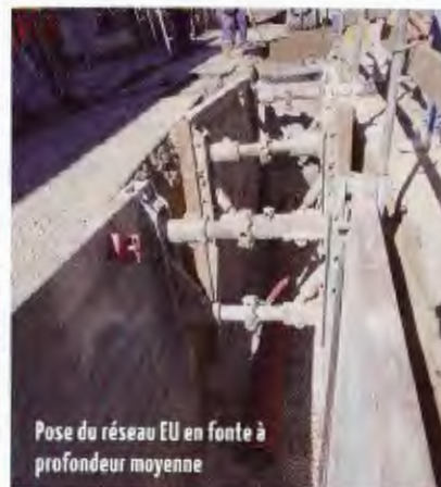
Dépose des canalisations amiantées, pose du nouveau réseau en fonte, remblaiement et compactage de la tranchée
