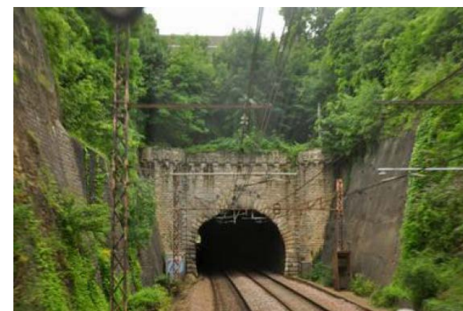
Tête nord du tunnel de Poitiers
