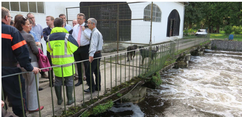
Echarcon, le 6 juin. Cet ouvrage hydraulique, qui a coûté 5 M€, a préservé Corbeil-Essonnes de la crue de l'Essonne. (LP/C. Ch.)
